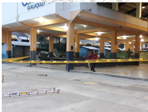
Centro comercial de Gualaquiza por afectaciones
