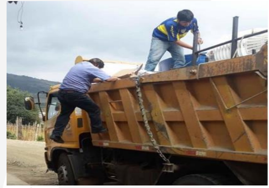
Foto 10: Desmontaje de la bodega en Chillanes, 15/09/2018
